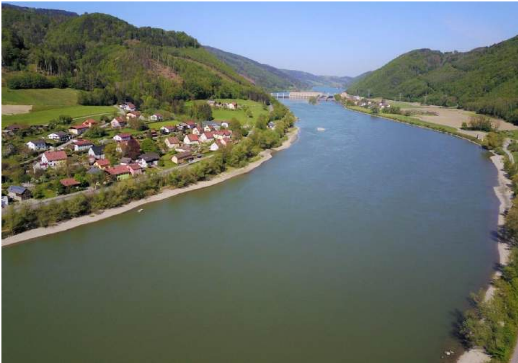
Abb. 159: Donau im Unterwasser des Kraftwerks Jochenstein
