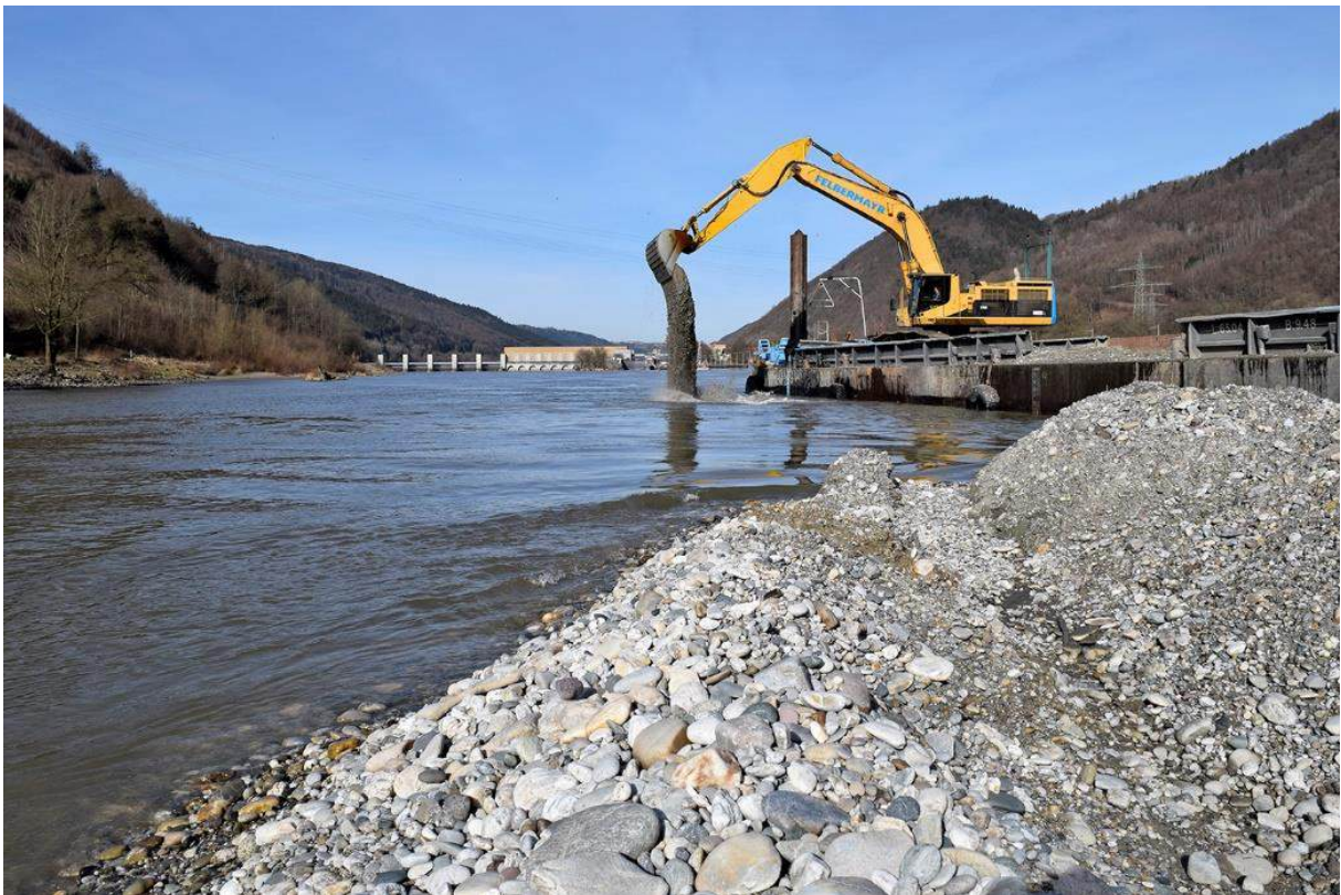
Abb. 150: Einbau von rückgeführtem Geschiebe in Form einer Kiesinsel (Unterwasser Donaukraftwerk Jochenstein)
