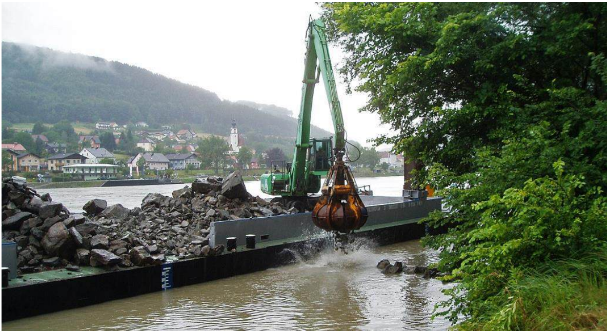
Abb. 167: Einbringen von Kurzbuhnen
