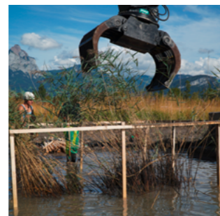
Am Flachufer wurde Schilf verpflanzt. Zum Frassschutz ist es im ersten Jahr noch eingezäunt.
