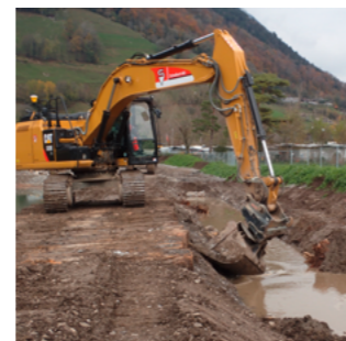
Bau des neuen Bachlaufes.
